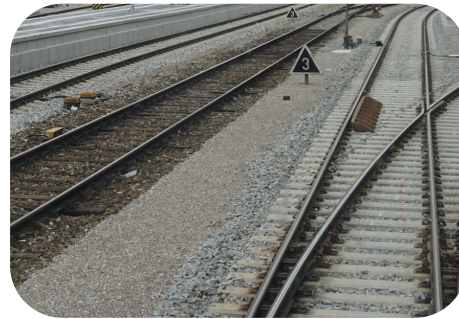
115 km neue Gleise
