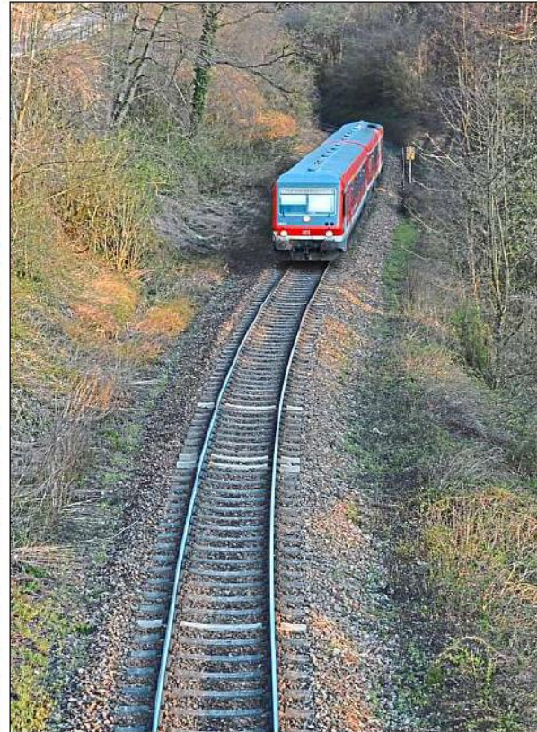
Der enge Halsbachgraben bei Burghausen bietet wenig Bewegungsspielraum für schwere Maschinen. Erst recht nicht, wenn hier „unter rollendem Rad“ gebaut werden soll und noch ein Ersatzgleis Platz finden muss. – Foto: Gerlitz
